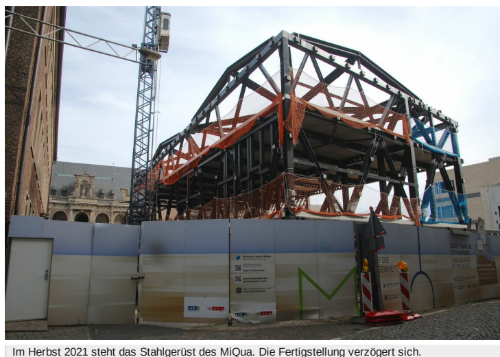
Im Herbst 2021 steht das Stahlger st des MiQua. Die Fertigstellung verz gert sich.
